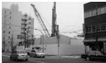
着工した80mマンション
